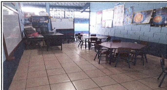
FOTO 4: Sustrucción de puertas, por puertas de metal de 1.20 x 2.20
