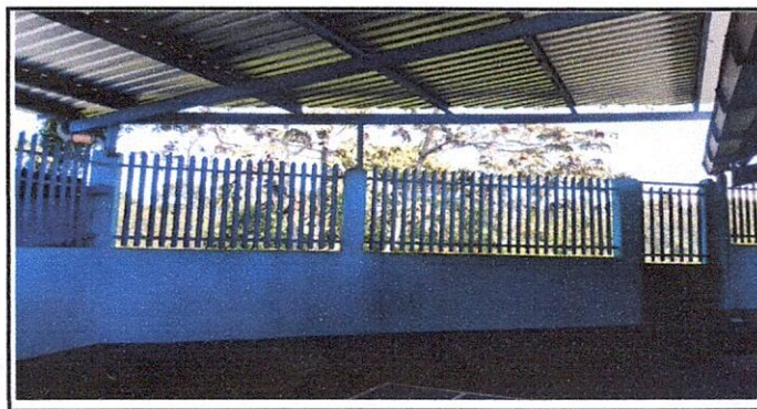
FOTO 6: Aplicación de pintura en muros interiores y exteriores
