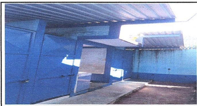
FOTO 5: Reparación de losa de patio de concreto t: 0.10
