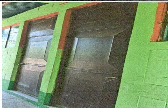
FOTO 1: Sustrucción de puertas por puertas de metal de 1.00 x 2.20
