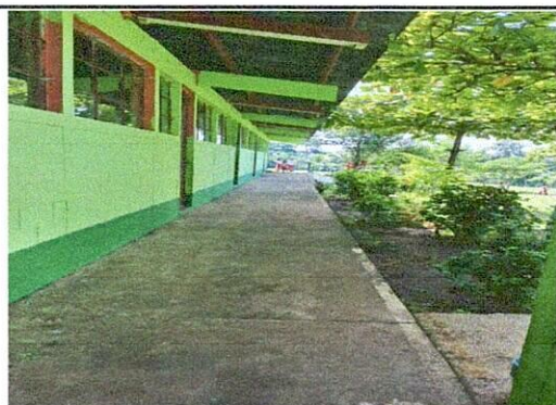
FOTO 3: Reparación de banqueta de concreto t: 0.10
