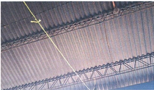
FOTO 3: Mantenimiento de estructura portante tipo joist de 16 m de largo c/joist (refuerzo, cepillado, pintado a 2 manos de pintura anticorrosiva R15 color azul)
