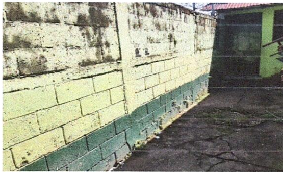
Foto1: Referencia renglón 1.1 (sustitución de muro perimetral).
