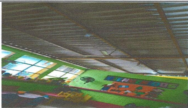
FOTO 1: Sustitución de lámina, por lámina troquelada aluzinc calibre 26, Sustitución de estructura de soporte de madera, por estructura de soporte de metal.
