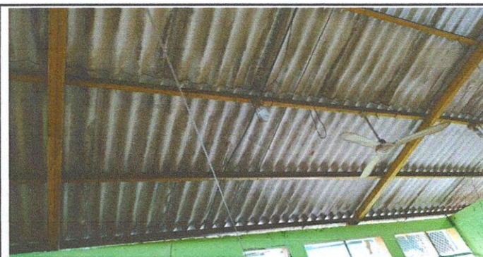
FOTO 5: Sustitución de lámina, por lámina troquelada aluzinc calibre 26, Sustitución de estructura de soporte de madera, por estructura de soporte de metal.
