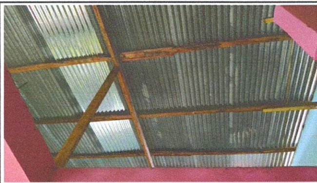
FOTO 4: Sustitución de lámina, por lámina troquelada aluzinc calibre 26, Sustitución de estructura de soporte de madera, por estructura de soporte de metal.
