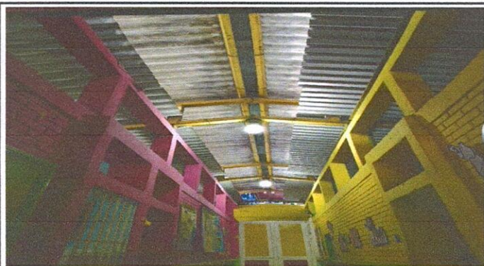
FOTO 3: Sustitución de lámina, por lámina troquelada aluzinc calibre 26, Sustitución de estructura de soporte de madera, por estructura de soporte de metal, Sustitución de capote de metal
