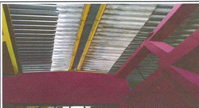
FOTO 6: Sustitución de lámina, por lámina troquelada aluzinc calibre 26, Sustitución de estructura de soporte de madera, por estructura de soporte de metal, Sustitución de capote de metal
