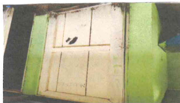
Foto 4: Sustitución de puerta
