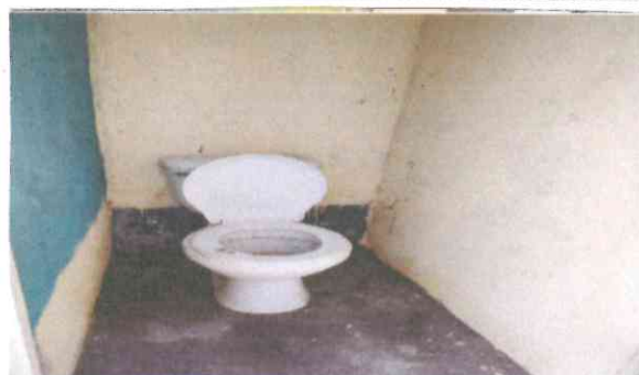
Foto 2: Suministro de azulejo, inodoro, piso
