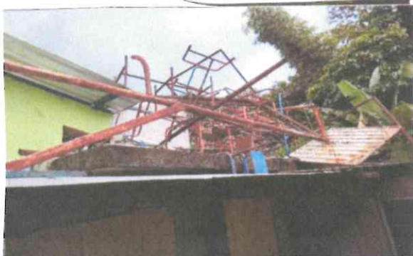
Foto 1: Sustitución de lámina, sustitución de depósito
