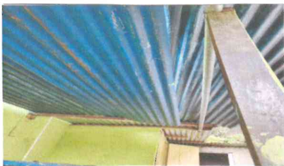
Foto 3: Sustitución de lámina
