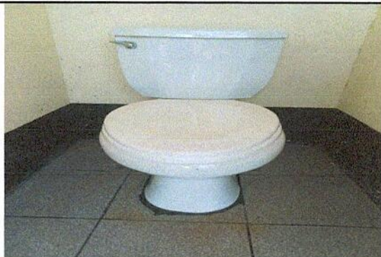
Foto1: Sustitución de inodoros en módulo de servicios sanitarios
