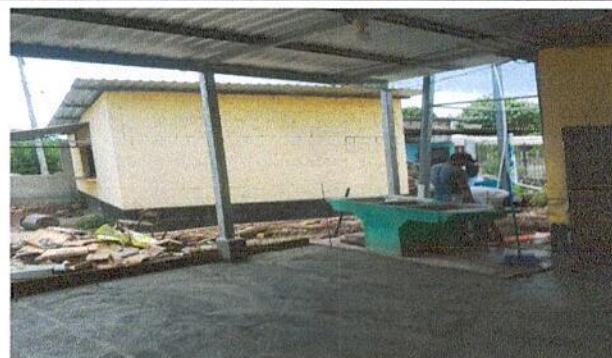
Foto 4: Sustitución de estructura de techo de lámina + suministro de losa de patio
