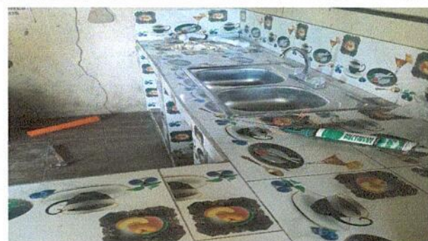
Foto 5: Suministro de gabinete de cocina + colocación de azulejo y piso cerámico
