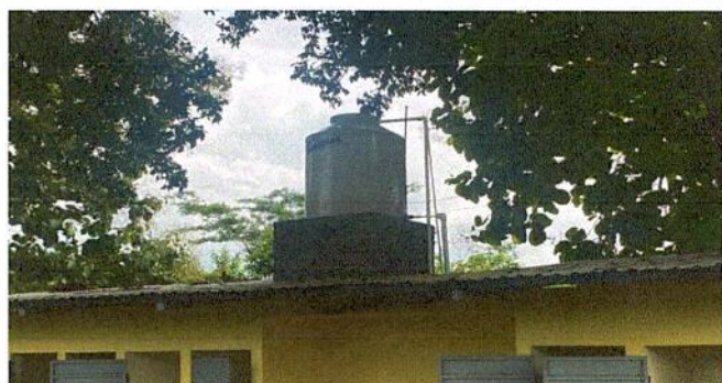
Foto 3: Sustitución de tanque elevado de 750 lt. Por tanque elevado de 1100 lt.
