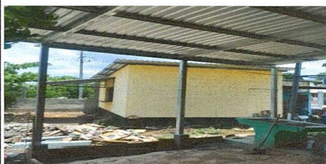
Foto 4: Sustitución de estructura de techo de lámina + suministro de losa de patio
