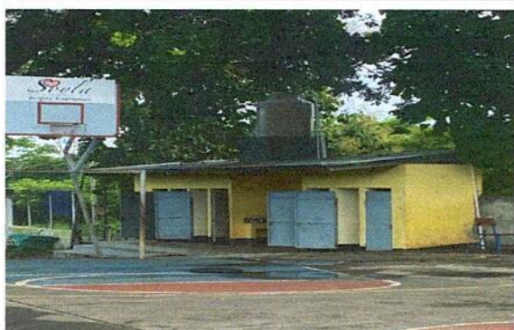
Foto 3: Sustitución de tanque elevado de 750 lt. Por tanque elevado de 1100 lt.
