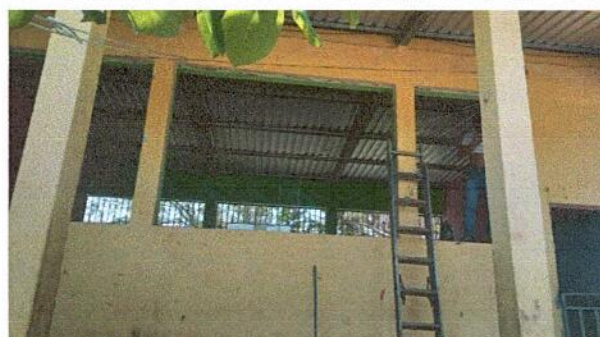
Foto 6: Sustitución de Balcones de metal
