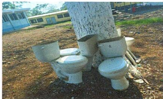
Foto1: Sustitución de inodoros en módulo de servicios sanitarios
