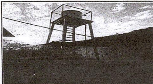
FOTO 3: Sustitución de tanque elevado de 750 lt por tanque elevado de 1100 lt
