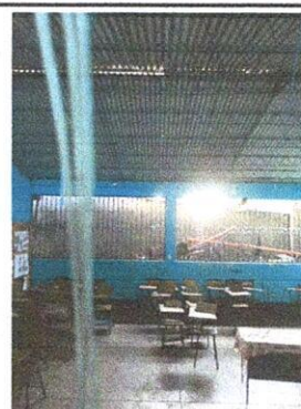
FOTO 3: Elevación de estructura portante de metal con levantado de muro h: 0.40 (2 hiladas)
