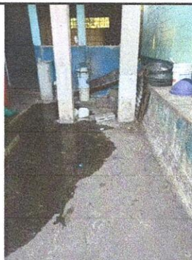
FOTO 1: Suministro de mesa de trabajo de concreto de 4.00 x 0.60 revestida de azulejo + espacio para ollas
