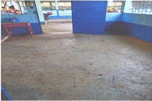
FOTO 1: SUSTITUCION DE PISO CERAMICO INCLUYE ADHESIVO + SISA EN COCINA
