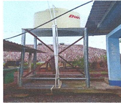
FOTO 2: SUMINISTRO DE ESCALONES DE METAL (0.445 X 3.00 MTS) DE TUBO GALVANIZADO PARA ACCESO AL DEPOSITO ELEVADO PARA ALMACENAMIENTO DE AGUA
