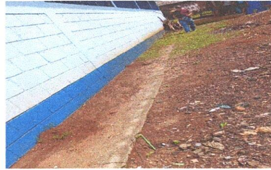
FOTO 4: SUMINISTRO DE BANQUETA DE CONCRETO + 1 HILADAS DE BLOCK FUNDIDO Y PINEADO CON HIERRO 3/8 + RELLENO DE SELECTO
