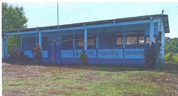
FOTO 5: SUMINISTRO DE CANAL DE PVC + ACCESORIOS+ PESCACNTE+ BAJADA DE AGUA PLUVIAL 3"
