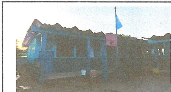
Foto. 1 Sustitucion de cubierta de lamina de adbesto por lamina troquelada calibre 26 y suministro de estructura de techo, incluye levantado de block para mejorar altura.
