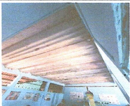
Foto. 3 Sustitucion de cubierta de lamina de adbesto por lamina troquelada calibre 26 y suministro de estructura de techo.
