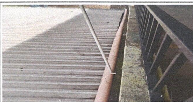
foto 11: Reparación de canal
