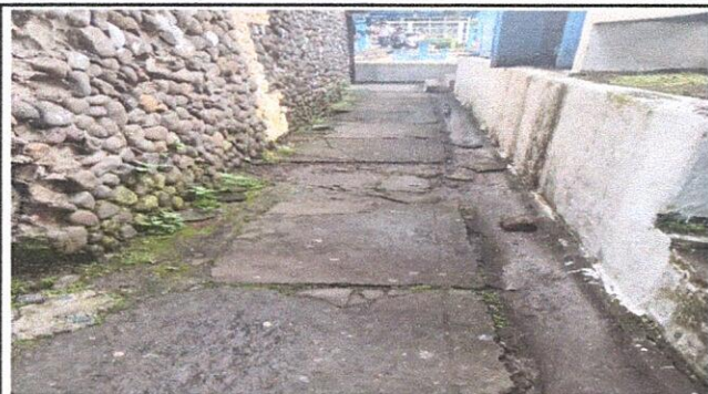
Foto 7: Reparación de cuneta de concreto
