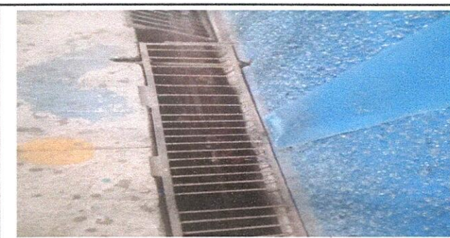
Foto 12: Sustitución de rejilla de metal
