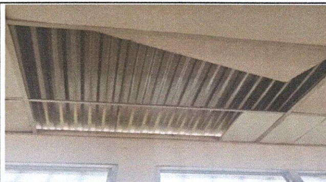
Foto 8: Sustitución de estructura de soporte de metal
