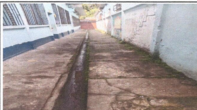
Foto 9: Reparación de cuneta de concreto
