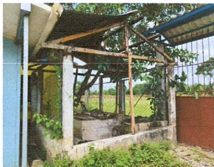
FOTO 1: SUSTITUCION DE GALERA
