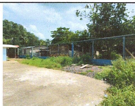
FOTO 4: SUSTITUCION DE LOSA DE PATIO
