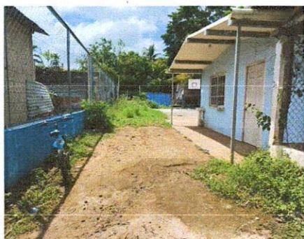
FOTO 5: SUSTITUCION DE LOSA DE PATIO
