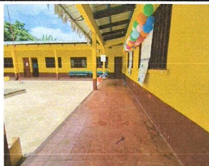
FOTO 6: SUSTITUCION DE PISO POR PISO CERAMICO
