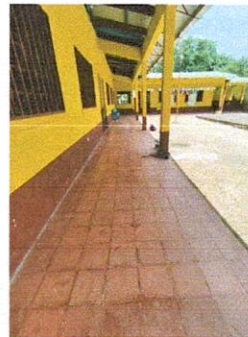
FOTO 2: SUSTITUCION DE PISO POR PISO CERAMICO + BASE DE CONCRETO + COMPACTACION DE SELECTO
