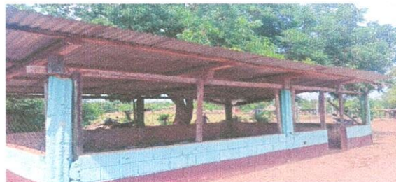
FOTO 2. Sustitución de malla por balcones
