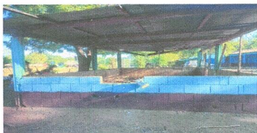
FOTO 3. Sustitución de lamina.
