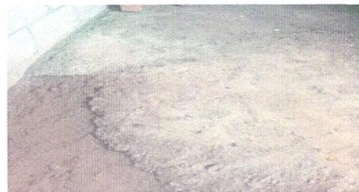
FOTO 4. Reparación de piso de concreto acabado pilido.
