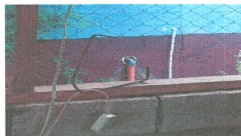
FOTO 6. Sustitución sistema electrico.
