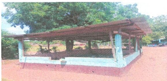
FOTO 1. Reparación de muro, columnas y soleras.
