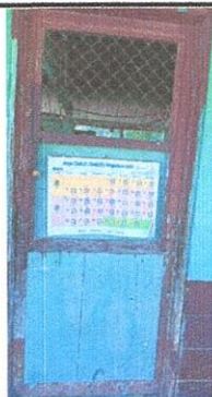
FOTO 5. Sustitución de puerta de madera por puerta de metal.
