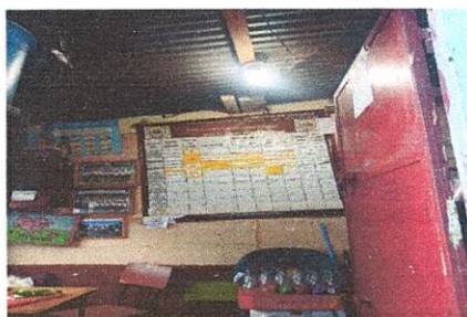
Foto 5: Referencia renglón 2.1 (sustitución de estructura de madera por estructura de metal para soporte de techo + lámina troquelada aluzinc calibre 26).
