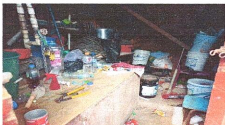
Foto 9: Referencia renglón 3.1 (Mantenimiento de pozo, limpieza, demolición y tallado de brocal).
