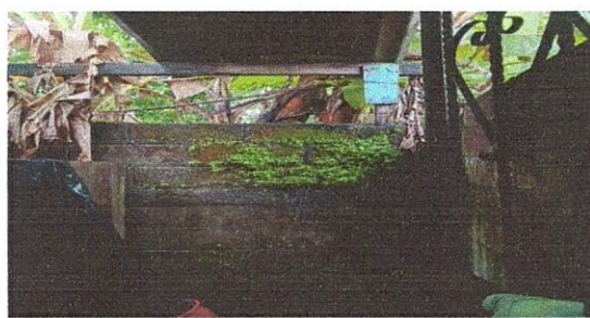
Foto 2: Referencia renglón 1.2, 1.3, 1.4, y 1.5 (suministro de balcón de metal, + Suministro de cedazo, + repello y cernido en pared, + instalación eléctrica).
