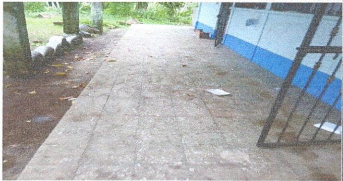
FOTO 2: INSTALACION DE PISO ANTIDESLIZANTE
