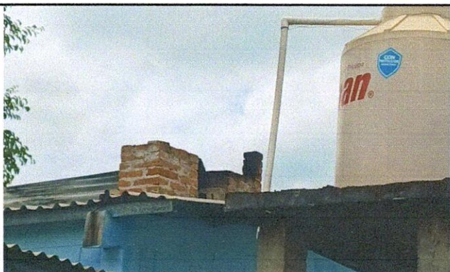
Sustitución de ladrillo de chimenea con protector de metal
