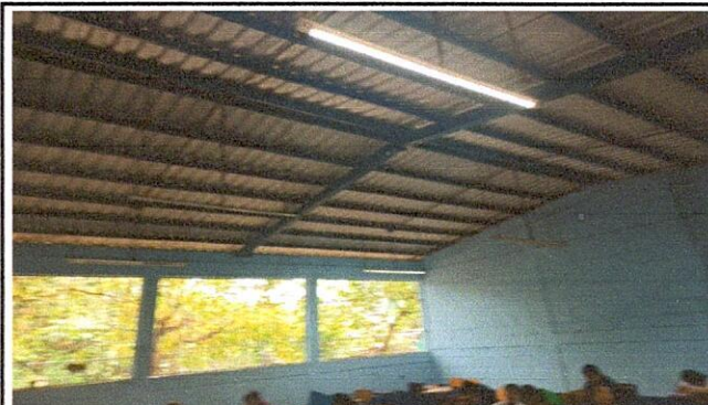
Instalación de sistema eléctrico en aulas.
