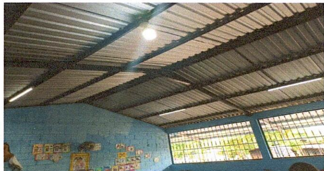
Suministro de cielo falso color blanco en aulas.
