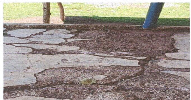
Sustitución de plancha de concreto por piso alizado.
