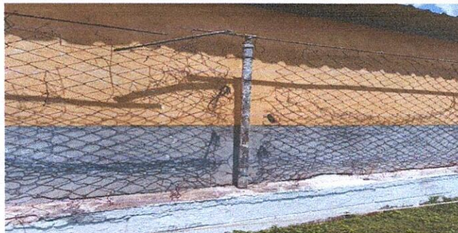
Sustitución de malla por malla.
