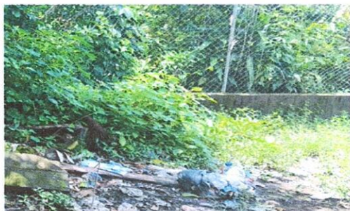
SUMINIISTRO DE POZO DE ABSORCION
