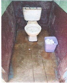
Suministro e instalación de piso ceramico antideslizante.
