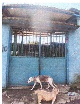
Mantenimiento de portón metálico de ingreso principal
