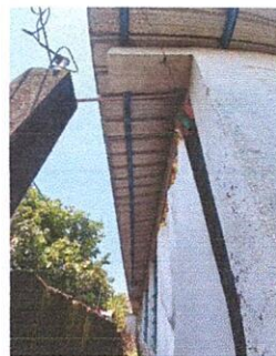
Suministro e instalación de canal metálico (Incluye pescantes metálicos) + Suministro e instalación de bajadas de agua pluvial de 3" de diámetro
