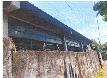
Levantado de Block de 0.14x0.19x0.39m sobre muro perimetral existente
