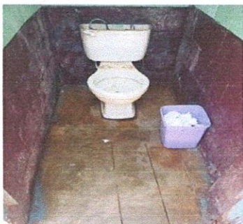
Sustitución de sanitario+ accesorios+ piso antideslizante + azulejo en muros.
