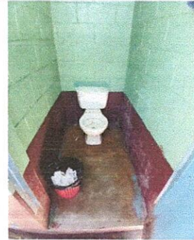
Suministro e instalación de azulejo en pared
