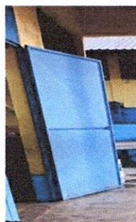
FOTO 6: SUSTITUCION DE PUERTA DE METAL
