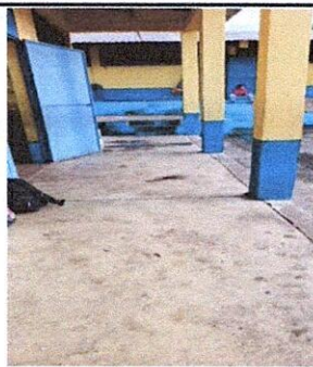
FOTO 2 : SUSTITUCION DE PISO POR PISO CERAMICO ANTIDESLIZANTE
