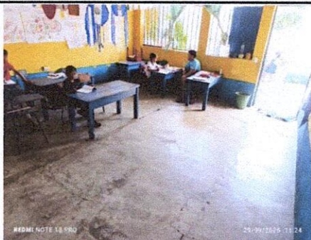
FOTO 1: SUSTITUCION DE PISO POR PISO CERAMIC
