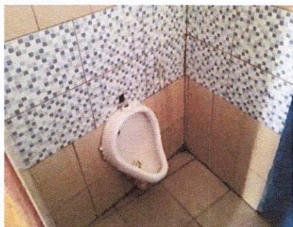
FOTO 3: SUSTITUCION DE MINGITORIO
