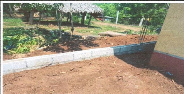
FOTO 4: Suministro de cerramiento de blok a tres hiladas + maya calibre 12 de 3/4 de abertura por 1.50 de altura
