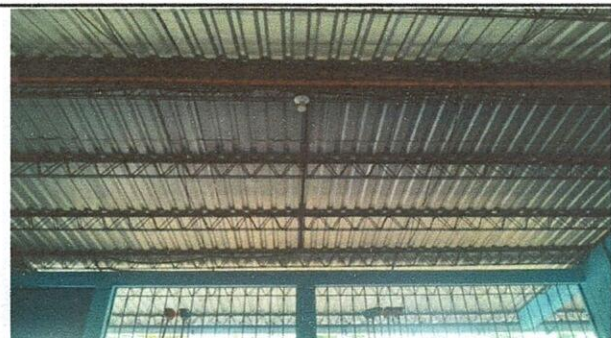
FOTO 5: Aplicación de pintura en Joist de estructura de techo de dos aulas de 18.50 mts de largo anticorrosiva color azul
