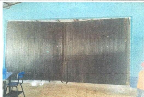
FOTO 2: Sustitución de puerta de madera por puerta de metal de 4 hojas abatibles para División de dos aulas
