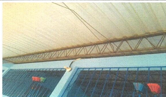
FOTO 1: Aplicación de pintura de techo en dos aulas color gris anticorrosiva.
