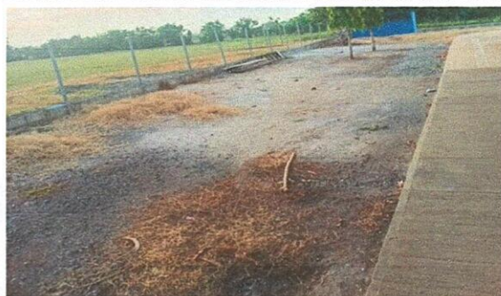
FOTO 3: Sustitución de losa de patio enfrente al aula en la entrada principal incluye el concreto armado de 8cms de espeso con electromaya 9/9
