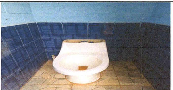
Sustitución e instalación de inodoros.
