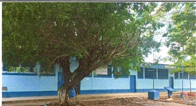
Suministro de balcones de metal en área de ventanas
