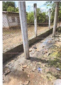
SUMINISTRO DE POZO DE ABSORCION 3 MTS X 1.20 DE DIAMETRO CON TAPADERA DE CONCRETO +RELLENO CON POMILLA AL EXTERIOR + RELLENO DE PIEDRA BOLA AL INTERIOR + RELLENO DE
