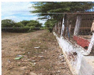
SUMINIISTRO DE POZO DE ABSORCION
