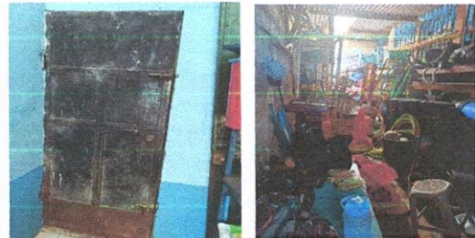
Foto 10: Referencia renglón 4.1, y 4.2 (sustitución de puerta de metal, + suministro de estantería de metal).
