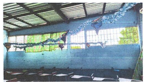
Foto 6: Referencia renglón 1.6, 1.7, y 1.8 (sustitución de pilotes operadores de aluminio para ventanas de paletas. Suministro para fundicion y tallado de marco de ventana. Sustitucion de ventana de paletas por ventana de pvc).
