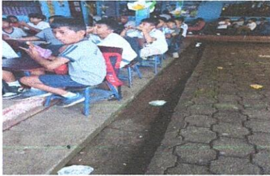
Foto 7: Referencia renglón 2.1 (Suministro de parrilla de metal para cuneta).
