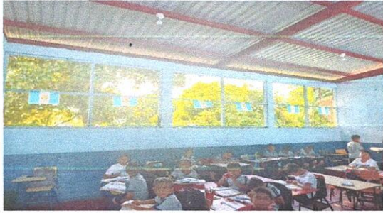
Foto 1: Referencia renglón 1.1 (reparacion de gotera en lamina).
