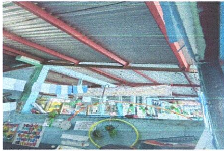
Foto 3: Referencia renglón 1.3 (suministro de balcon de metal)
