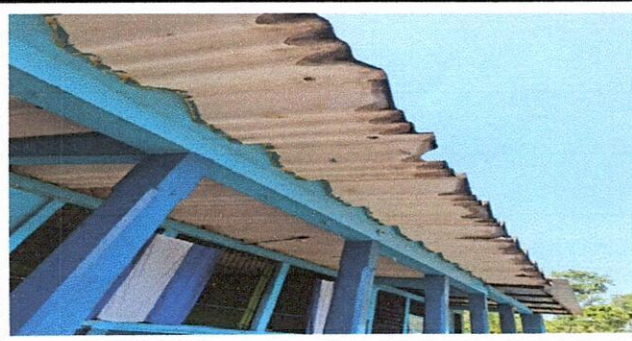
Foto 6: Sustrucción de cubierta de lámina de asbesto por lámina troquelada calibre 26 y suministro de estructura de techo, incluye levantado de block para mejorar altura.
