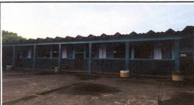
Foto 4: Sustrucción de cubierta de lámina de asbesto por lámina troquelada calibre 26 y suministro de estructura de techo, incluye levantado de block para mejorar altura.
