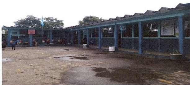
Foto 3: Sustrucción de cubierta de lámina de asbesto por lámina troquelada calibre 26 y suministro de estructura de techo, incluye levantado de block para mejorar altura.
