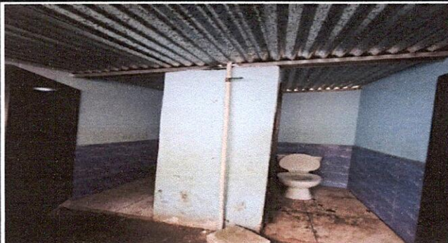
Foto 2: Sustrucción de cubierta de lámina por losa de concreto para instalación de depósito de polietileno
