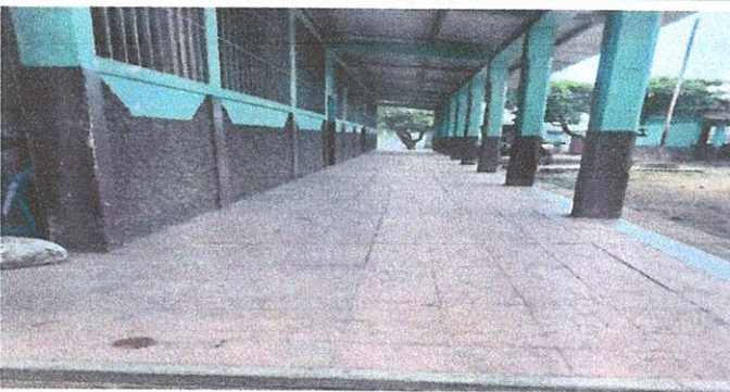
Foto 3: Sustitución de piso de concreto por piso cerámico y aplicación de pintura en muros interiores y exteriores
