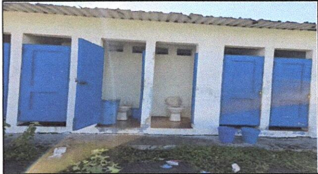
CAMBIO DE LAMINA, REPARACION DE BANQUETA, INSTALACION DE PUERTA
