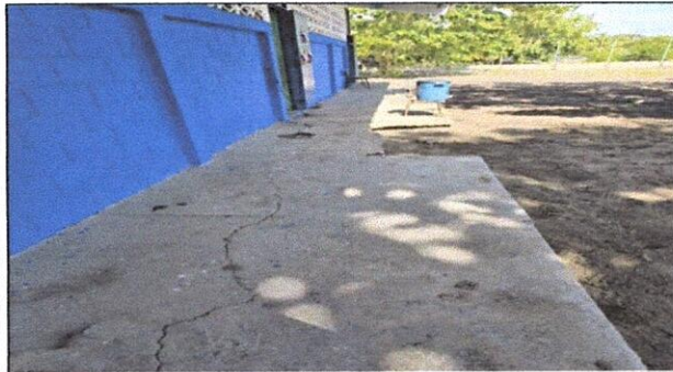
REPARACION DE BANQUETA
