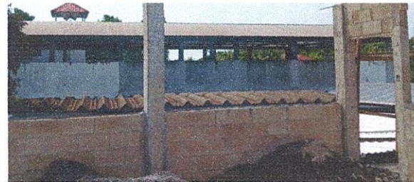
suministro de balcón de metal y puerta de metal
