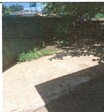
FOTO 3: SUMINISTRO DE BANQUETA DE CONCRETO
