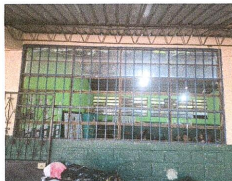
FOTO 4: SUMINISTRO DE BALCONES DE METAL
