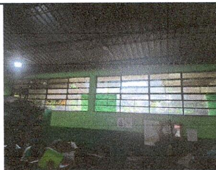
FOTO 6: SUMINISTRO DE BLACON DE METAL
