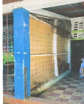
Suministro de electromalla en pared
