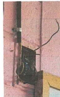
Sustitucion de tablero de 2 polos, incluye 2 flip-on de 20A y 200 ML de cableado #10 THHN
