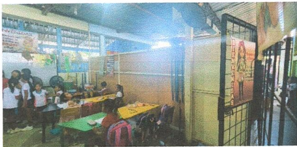
Sustitucion de estructura de madera por estructura de metal
