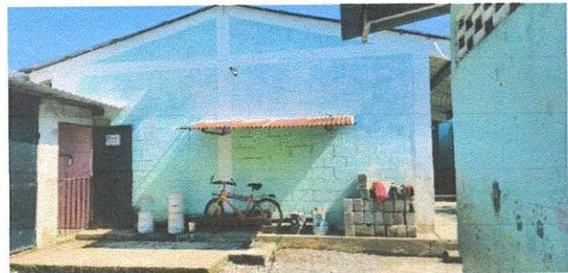
Suministro de ventana de metal de 1.40X0.90mt, incluye tallado del boquete
