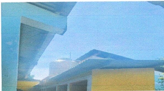
Sustitución de cubierta de lamina por lamina troquelada calibre 26
