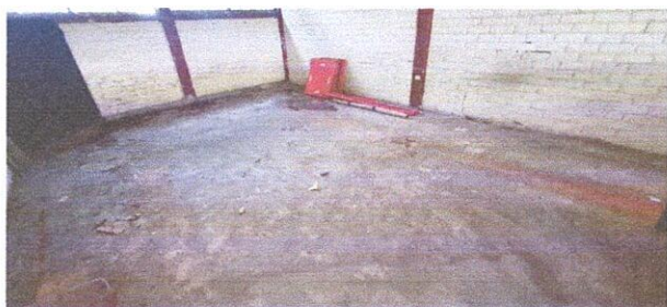
FOTO 3: SUSTITUCION DE PISO POR PISO CERAMICO
