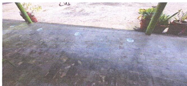
FOTO 4: SUSTITUCION PISO POR PISO CERAMICO EN CORREDOR
