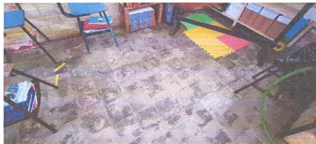
FOTO 2: SUSTITUCION DE PISO POR PISO CERAMICO + ESCAVACION+ RELLENO+ COMPACTACION+ BASE DE CONCRETO
