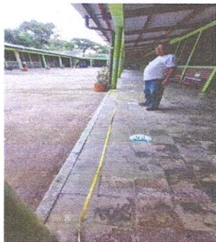
FOTO 1: SUSTITUCION DE TUBERIA DE CONCRETO POR TUBERIA DE PVC EN PATIO
