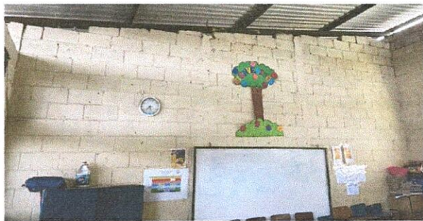
SUMINISTRO DE MURO DE TABLA YESO + DEMOLISION DE MURO PARA AMPLIACION DE AULAS
