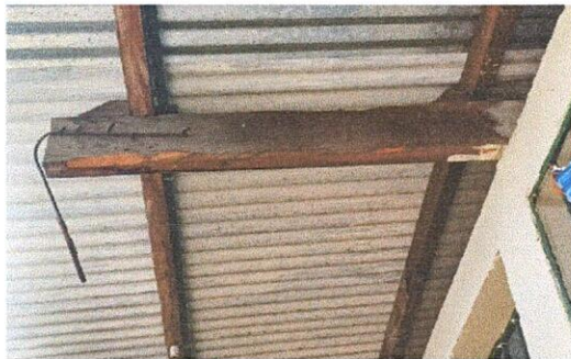
SUSTITUCION DE VIGAS DE MADERA
