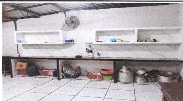
SUSTITUCIÓN DE PUERTAS EN LA COCINA
