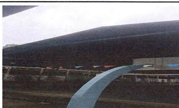
CAMBIO DE TECHO A LA CANCHA DEPORTIVA
