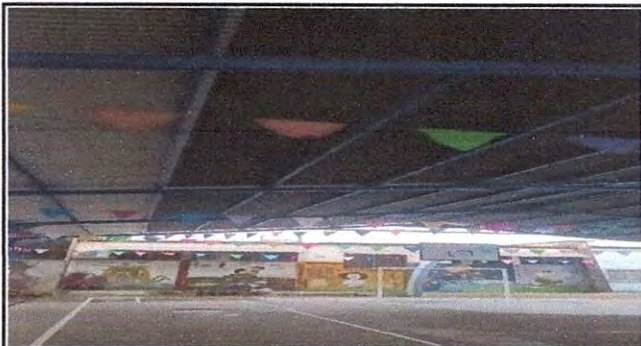
CAMBIO DE TECHO A LA CANCHA DEPORTIVA
