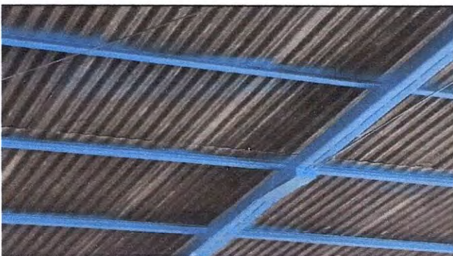
sustitución de estructura portante de metal (costaneras+tubos rectangulares)
