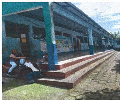
FOTO 5: SUSTITUCION DE TORTA DE CONCRETO POR PISO CERAMICO EN GRADAS (INCLUYE PSP)
