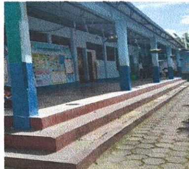
FOTO 6: SUSTITUCION DE TORTA DE CONCRETO POR PISO CERAMICO EN GRADAS (INCLUYE PSP)
