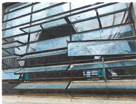
FOTO 2: SUSTITUCION DE VENTANAS DE MADERA Y METAL POR BALCONES DE METAL 85.32 M2
