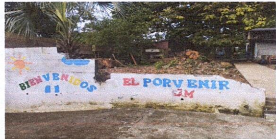
Foto 8: Referencia renglón 2.3, y 2.4 (suministro de material para reparación de muro existente incluye soleras y columnas de concreto armado. + Repello y cernido).
