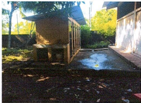
Foto 1: Referencia renglones 1.1, 1.2, 1.3, 1.7 (levantado de muro existente, migitorios, estructura de techo + lamina, lavamanos).
