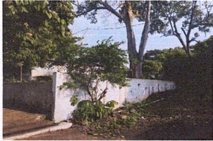
Foto 7: Referencia renglón 2.2 (suministro de baranda de metal, para protección en muro, cancha de basquetbol).
