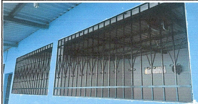
Foto 4 Sustitución de balcones
