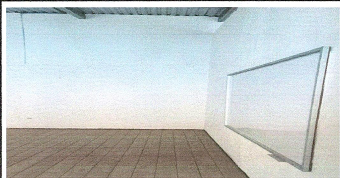
Foto 3: Sustitución de repello y cernido
