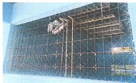
Foto 4 Sustitución de balcones
