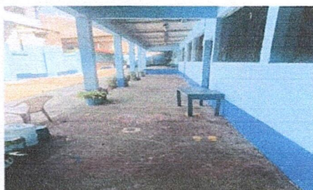
Foto 5. Sustitución de balcones
