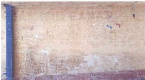
FOTO 5: Pintada de pared exterior
