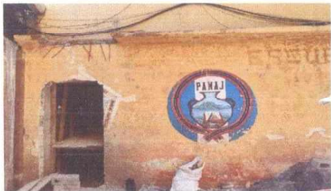
foto 7. Demolicion de muro perimetral y colocacion de columna.
