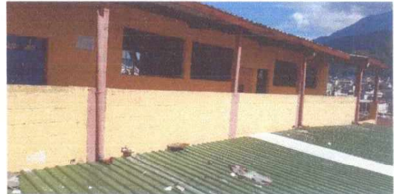
FOTO 4: Colocación de bajadas de agua pluvial
