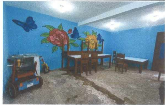
Foto 2: Colocación de piso cerámica para cocina escolar para una adecuada preparación de alimentos.
