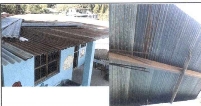
Foto 6: sustitucion de laminas por filtracion de agua
