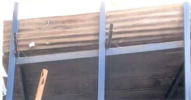
Foto: 1 Se colocará la estructura metálica del techado de la cancha de basquet bol, se ubica en el tercer nivel de la escuela, para proteger a los niños ante la lluvia y sol.
