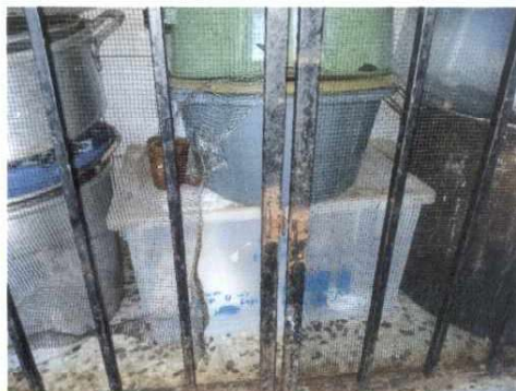
Foto 2. El lugar y las rejas donde se guardan los utensilios de cocina deteriorados y oxidados.
