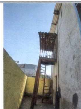
Foto 6. Ese espacio tampoco tiene techo, por lo que las gradas de metal se terioran (oxidán) por la lluvia.
