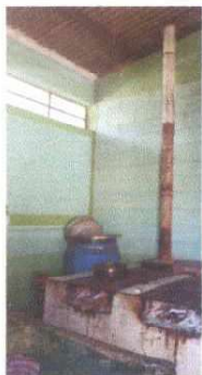
FOTO 7. CHIMINEA Y PILA DE LA COCINA DETERIORADA
