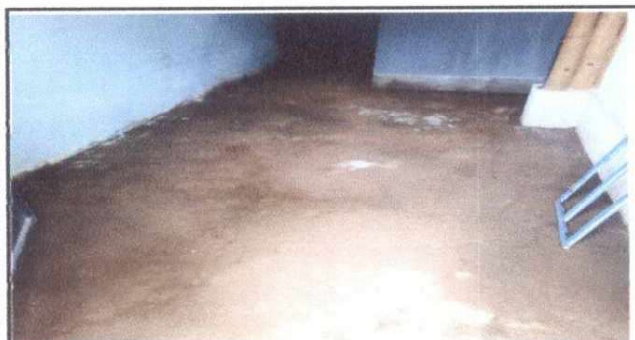
Foto 3. Instalación de piso de granito para servicios sanitarios.
