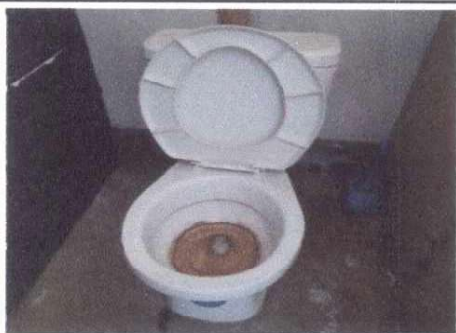
Foto 7. Sustitución de servicios sanitarios y accesorios.
