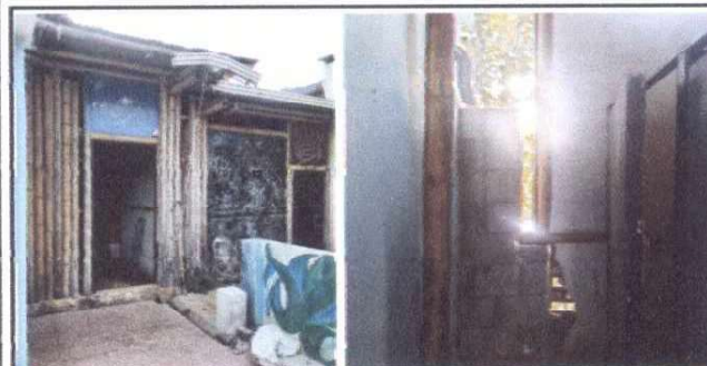
Foto 5. Pintada de paredes interior y exterior.
