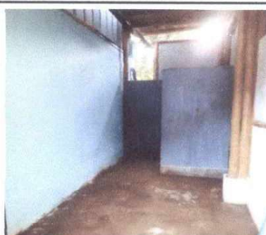
Foto 8. Instalación de servicio eléctrica en servicios sanitarios.
