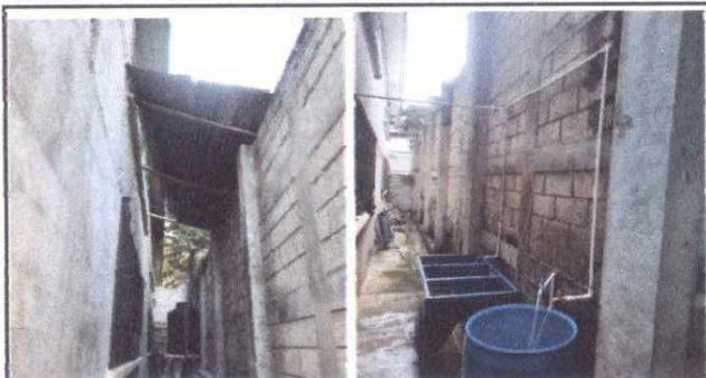
Foto 1. Techado de lavatrastos con lámina de zinc calibre 26.
