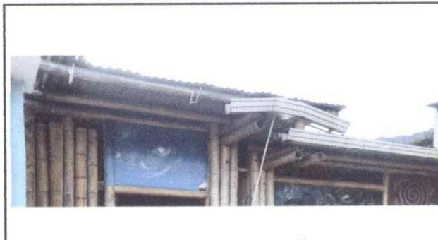
Foto 4. Instalación de canal para bajada agua pluvial.
