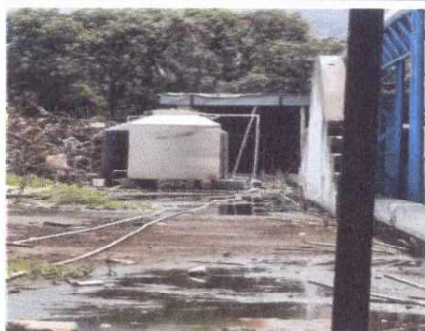
Foto 9. Instalación de un depósito de agua.
