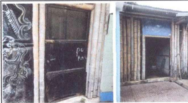
Foto 2. Instalación y sustitución de dos puertas de metal.
