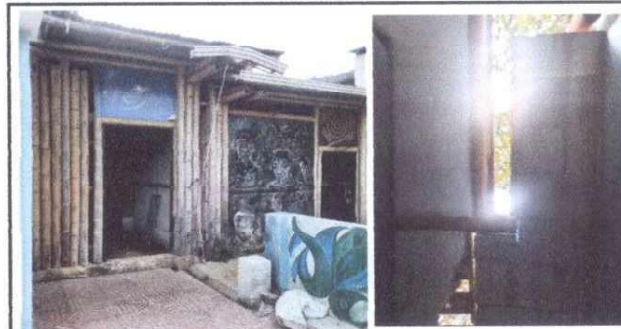
Foto 6. Sustitución y reparación de paredes de block.
