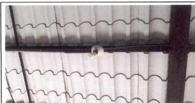
Foto 5: SISTEMA ELECTRICO EN CONDICIONES DE USO MUY PESIMAS, Y DETERIORADAS
