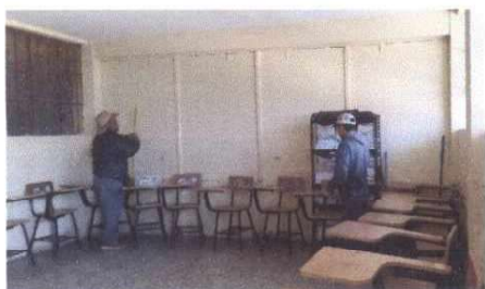
FOTO 5: Las paredes son de madera y ya se estan deteriorando, es necesario colocar block.
