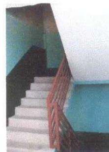
FOTO 6: las gradas de cemento se está deteriorando y es necesario colocar piso.
