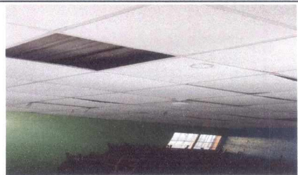
foto 6. Estructura de techo
