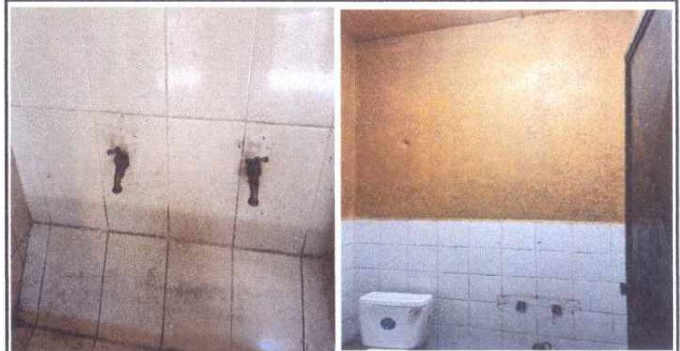
Foto 4. Reparación y mantenimiento de drenaje
