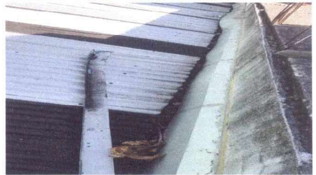
Foto 2. Limpieza, mantenimiento y corrección de agua pluvial.
