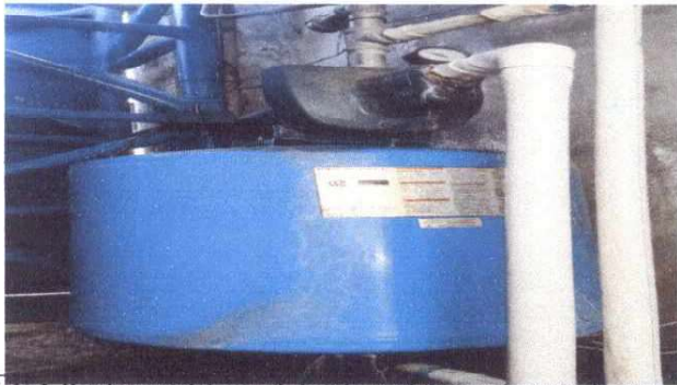
Foto 1. Cambio e instalación de bomba centrífuga y depósito de agua.
