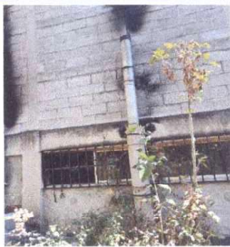
Foto 1. Reparacion de chimenea
