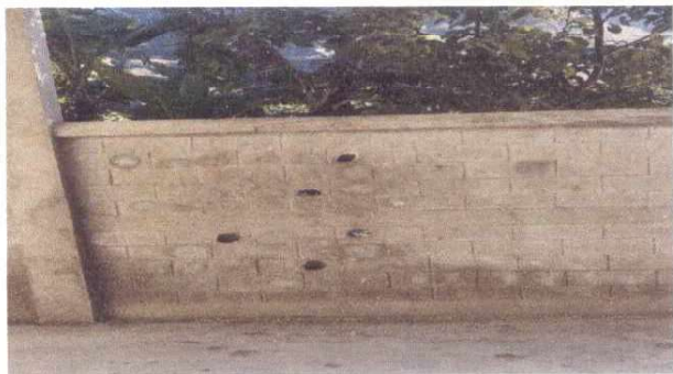
Foto 3. Reparacion de cerco o muro perimetral
